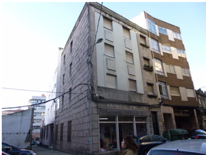
Situación actual : no primeiro plano o edificio obxecto de sentenza
