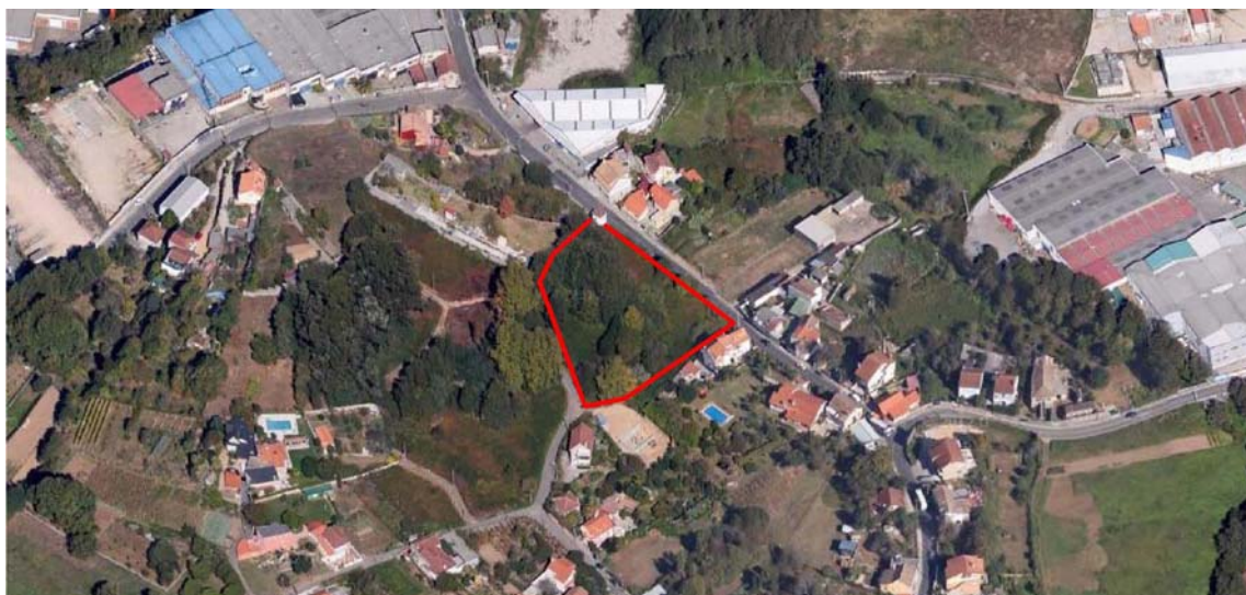
Imaxe 1: Situación actual do ámbito territorial obxecto de modificación (Vista aérea dende o sur-oeste).
