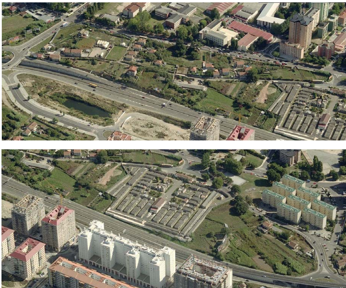
Fig. 27. Etapa VI, estado actual.
