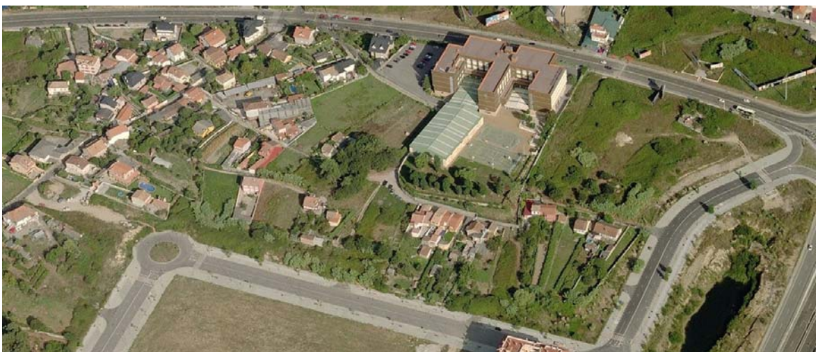
Fig. 26. Etapa V, estado actual.
