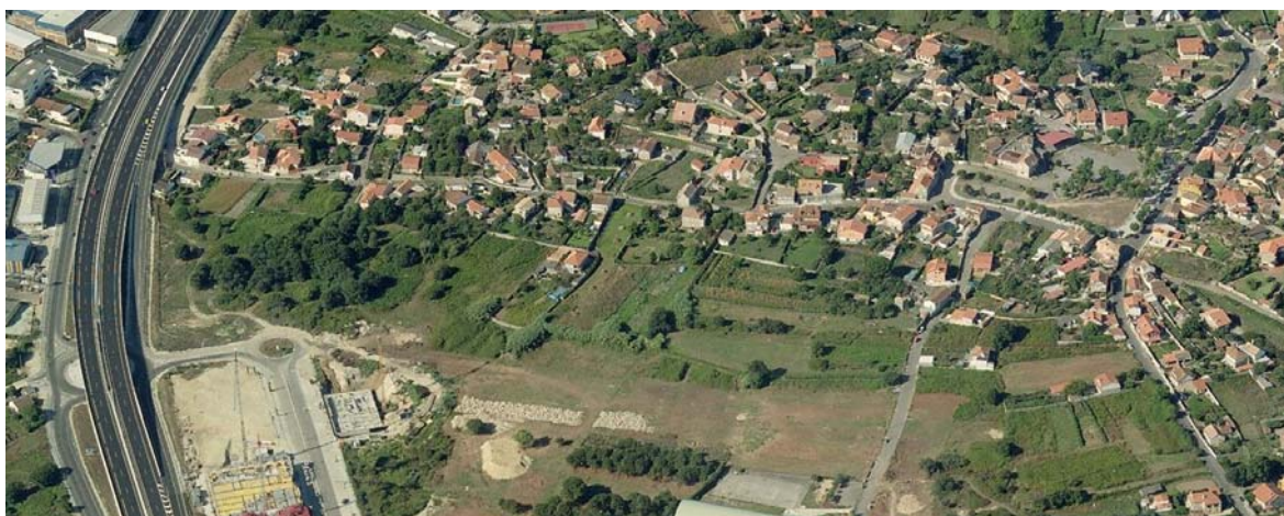
Fig. 24. Etapa III Fase B, estado actual.
