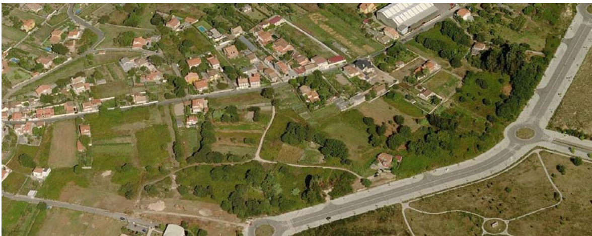
Fig. 25. Etapa IV, estado actual.
