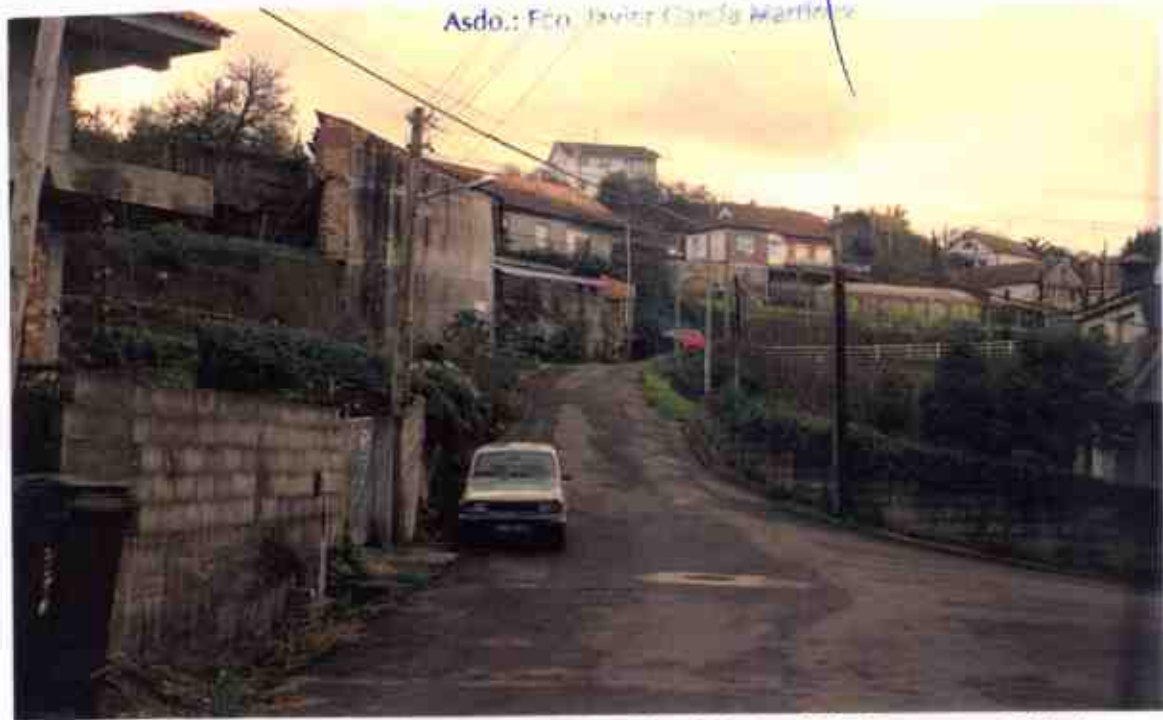
11 O VIARIO : Cruce das Estr. de Mandín, Subda. Miraflores e Cº Freires
