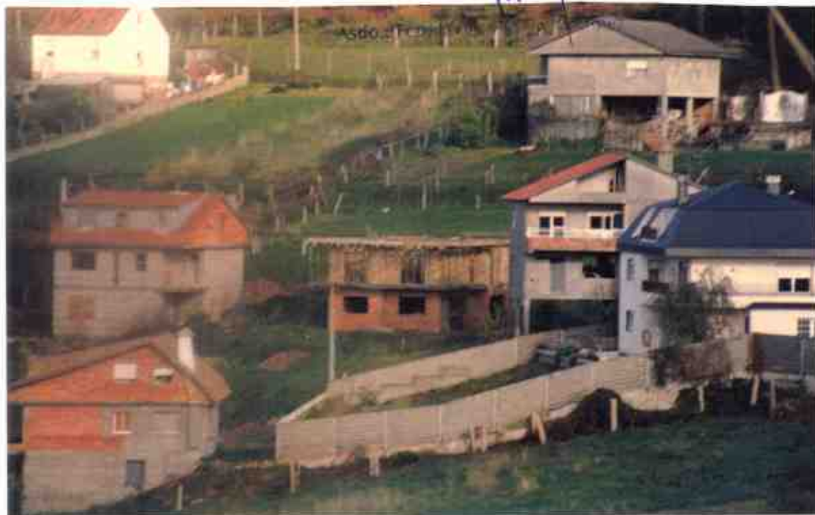
19 O DETERIORO DO NÚCLEO : Tipoloxías, materiais e volumes fora de contexto
